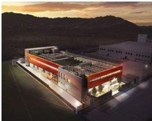
Figura 1 – Data Center IT1
